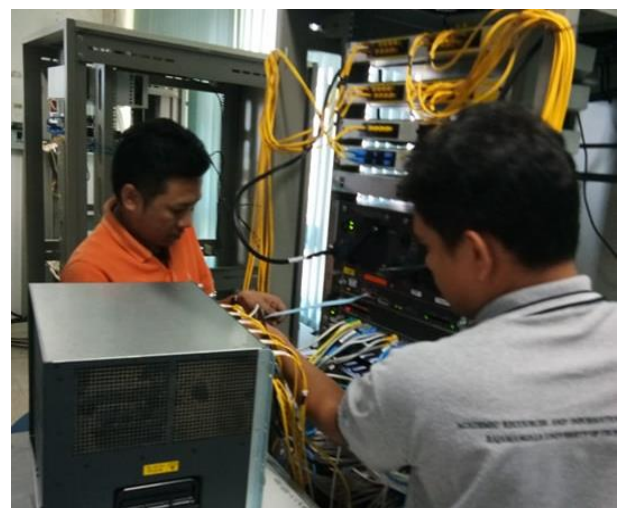
ภาพแสดง การติดตั้งอุปกรณ์กระจายสัญญาณภายในห้องคอมพิวเตอร์แม่ข่าย
