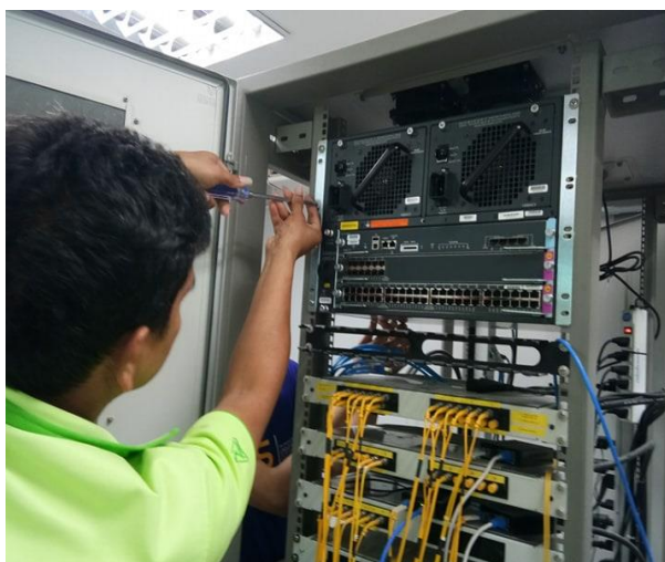
ภาพแสดง การติดตั้งอุปกรณ์กระจายสัญญาณภายในห้องคอมพิวเตอร์แม่ข่าย
